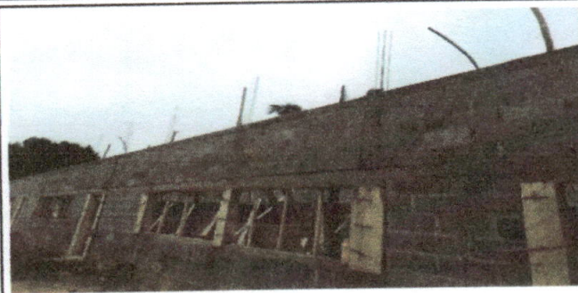
Foto 1: ESTRUCTURA DE TECHO
