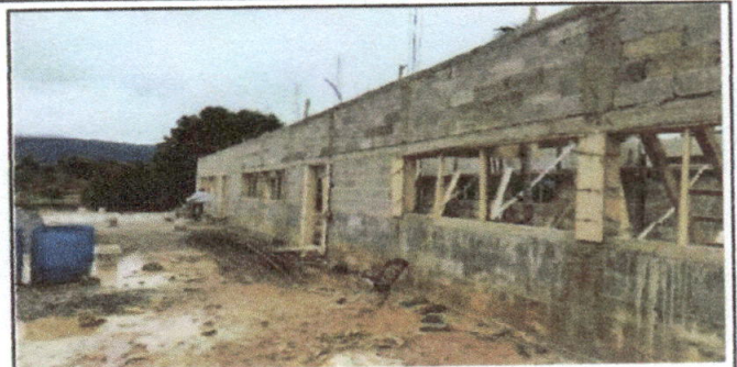
Foto 2: CUBIERTA DE LAMINA
